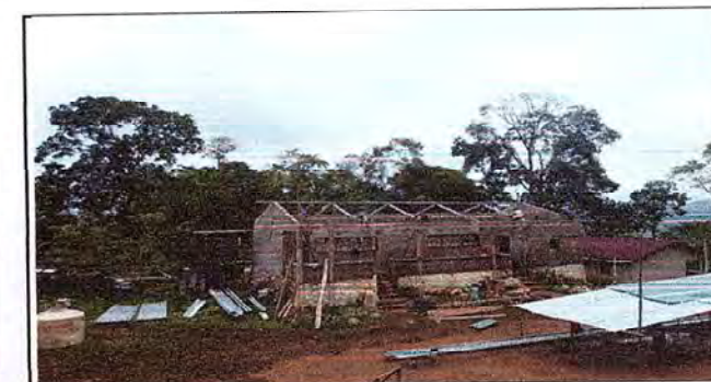
Foto 6: Colocacion de estructura metalica nueva
