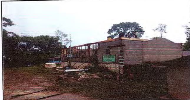
Foto 2: Colocacion y fundicion de solera frontal
