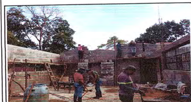
Foto 5: Trabajo de obra de construccion
