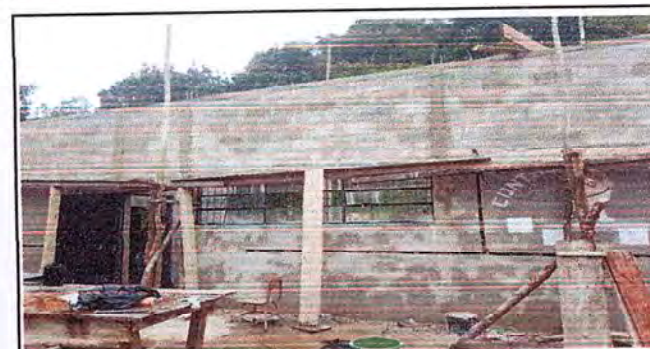
Foto 4: Parte final de hiladas de block y solera, referencia en la parte modular de la escuela.
