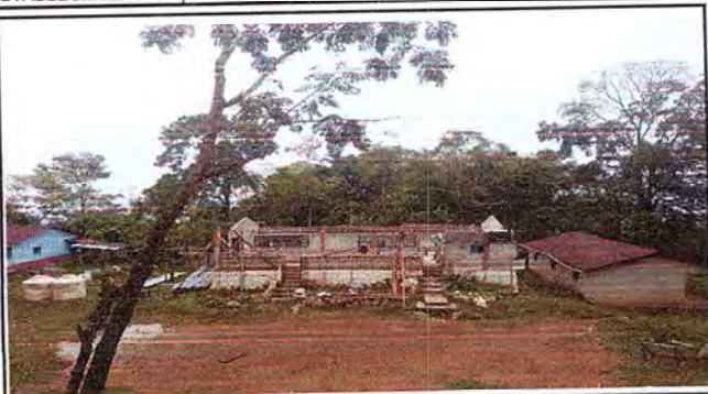
Foto 1: Desmontaje de estructura de laminas e inicio de trabajo de albañileria
